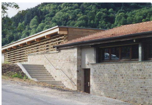
Vue depuis la rue du village : la salle des fêtes existante a été conservée et intégrée à l'ensemble par un habillage en pierres
