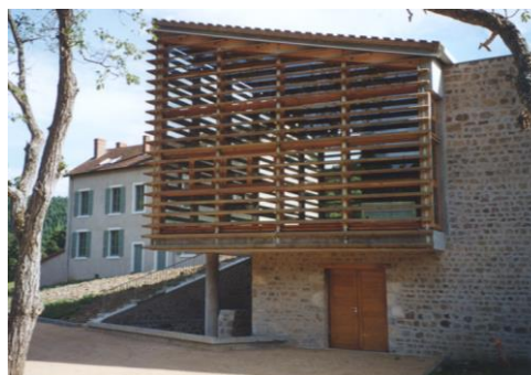
Le volume de l'atelier avec la mairie rénovée au second plan.
