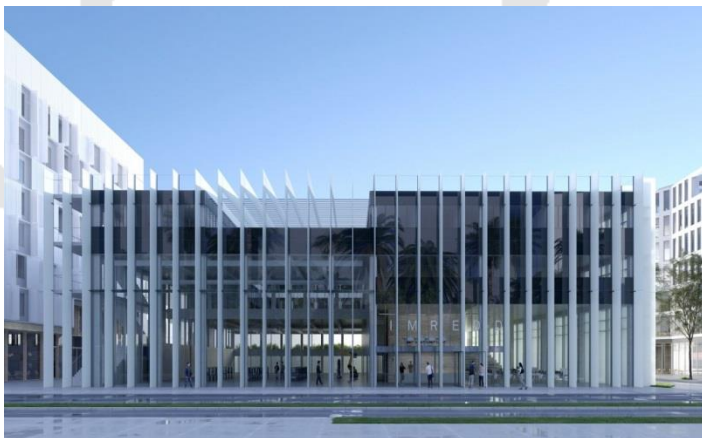
Façade. Source : Atelier Marc Barani
