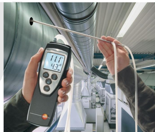
Mesure de débit sur une centrale de traitement d'air
