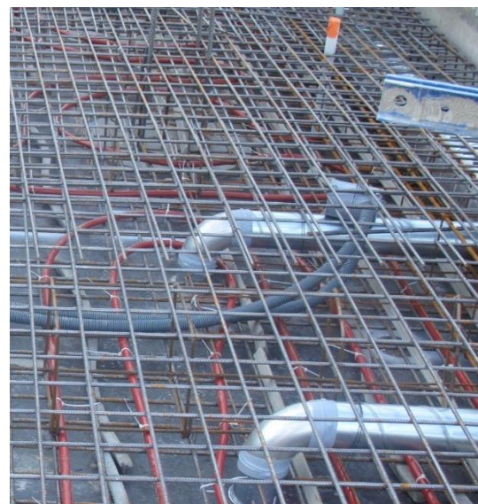
Mise en œuvre de la dalle active, intégrant les réseaux de ventilation
