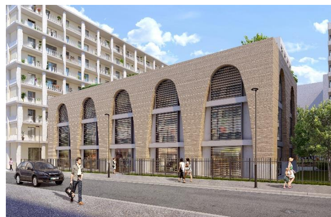
Immeuble tertiaire en pisé à Lyon Confluence (69). Crédit : Clément Vergély Architecte
